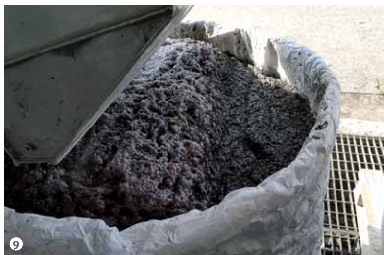
Figura 9: Il contenitore dei residui fangosi è sostituito ogni due settimane e smaltito ogni 6 mesi.
